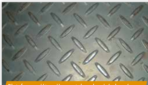
Plateforme piétonnière en tole galvanisée larmée
